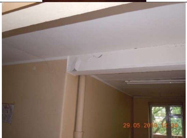
Fotofiksācija Nr.171 Telpa Nr.1, telpu grupa Nr.008 Konstatēta plaša sijas balstījuma vietā
