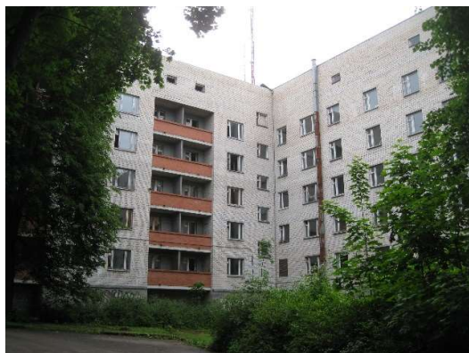
Skats uz dienesta viesnīcu Biešu ielā 4 (01000540055002)
